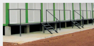
Terrassement et fondations
